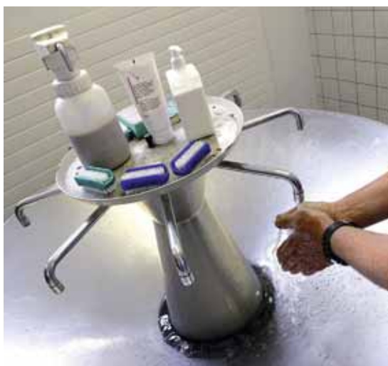
Figura 17: stazione di lavaggio in un'azienda del settore metallurgico con diversi detergenti in funzione del tipo di sporcizia.
